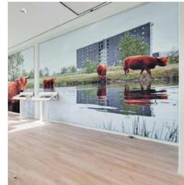
Suggestie voor identiteitsuitingen voor instituten: Akoestische (wandvullende plint tot plafond) wandpanelen met vervangbaar geprint doek.
