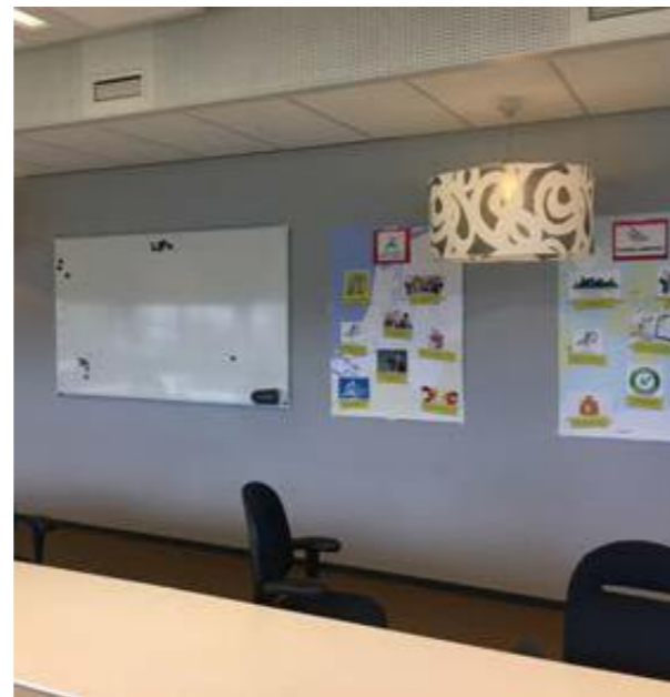
Niet-gebouwegebonden wandelementen worden verwijderd door de gebruiker. Wanden nagaan, herstellen waar nodig en sausen.
